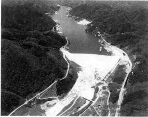
福島県いわき市 摺上川ダム試験湛水状況写真
